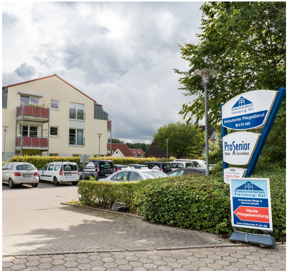
Am Saturnbogen Flensburg: Hier sind die Diakoniestation und Service-Wohnungen beheimatet. Fotos: Egerland
