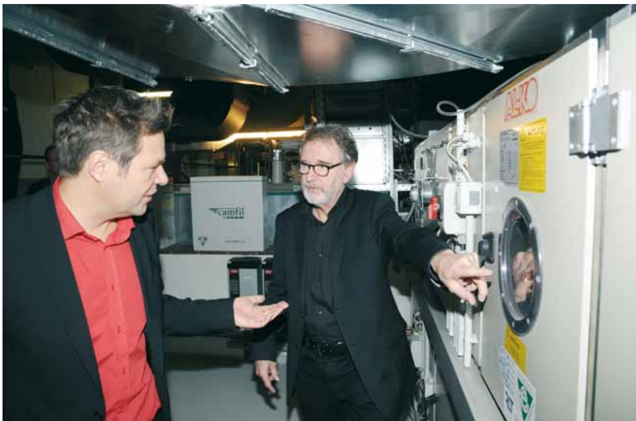
Ließ sich die Energieeinsparungen vor Ort genau erklären: Umwelt- und Energiewende-Minister Robert Habeck (l.) mit dem technischen Leiter der DIAKO, Fritz Petersen, in einer der Klimazentralen des Diakonissenkrankenhauses.
